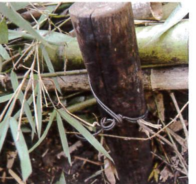
急傾斜の荒れた竹林に空気の通り道をつくる。伐った竹の枝を払って、土留めに利用する。道づくりは削った土を谷側に盛り、杭と土の間に伐採した竹と枝を鉛錆込んで番線で留めていく。「番線が腐蝕する頃には、この土を盛った部分にも植物たちの根が生えて道が崩れることはない」と矢野さん。
